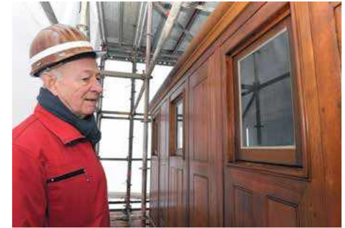
Das Kartenhaus ist fertig renoviert – zumindest äußerlich. Von der Inneneinrichtung und dem großen Steuerrad davor ist nichts erhalten geblieben.
