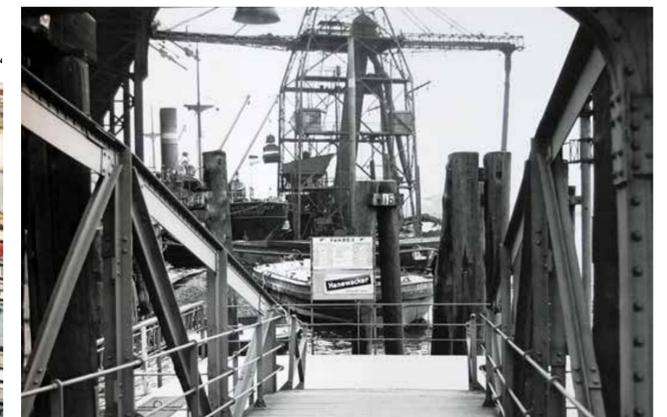
1934: Der Ponton des Fähranlegers an der Harburger Straße. Im Hintergrund wird Kohle mit einem schwimmenden Kohlenheber aus einem Frachter in Schuten umgeschlagen.
