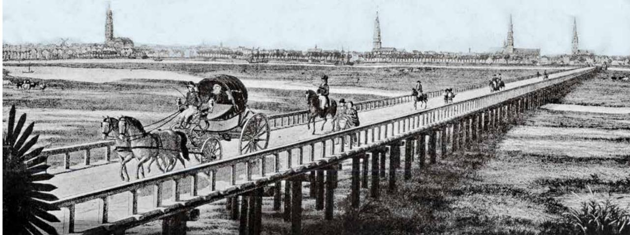
Auf dem Bild die Holzbrücke über den Grasbrook, Teil der 4,1 Kilometer langen Verbindung von Hamburg bis Harburg. Rund 5.500 Soldaten und Handwerker bauten diese Brücken in nur 83 Tagen, so ist es überliefert.
