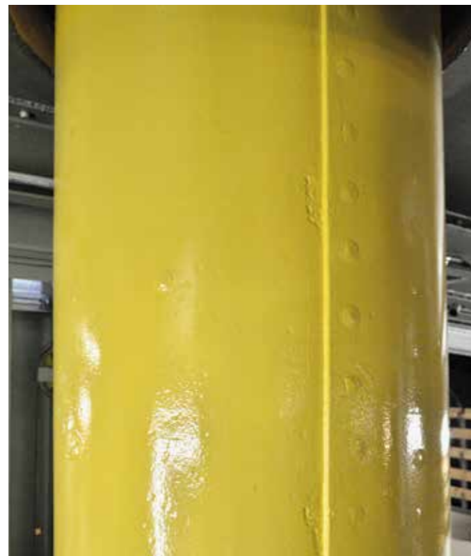
Segelmast: frisch lackiert. Statt einer klassischen Schweißnaht sorgen echte Nieten für höchste Stabilität wie es 1911 üblich war.
