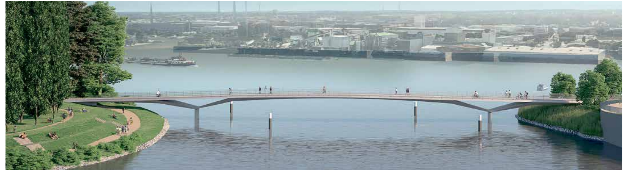
Bauherrenwunsch und die neue Radfahrer- und Fußgängerbrücke zwischen HafenCity und Entenwerder Park: „Ganz wichtig wäre, zum frühestmöglichen Zeitpunkt die Brücken in die Nachbarschaft zu bauen: die Brücke zwischen Grasbrook und Veddel, zwischen Grasbrook und HafenCity und zwischen HafenCity und Rothenburgsort. Die Stadtteile sollen zusammenwachsen können.“
