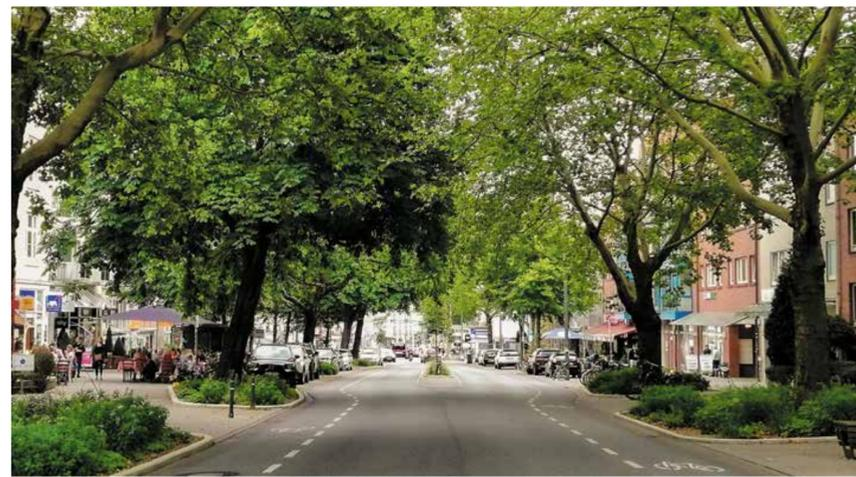
Zweispurig ausgebaute Hauptverkehrsader Osterstraße: Raumbreite ca. 33 Meter, 2 Kfz.-Spuren abwechselnd mit/ohne Mittelgrün, begrünte Bauminseln, belebte Gehwege. Verkehrsbelastung: Frequenz bis zu 13.000 Kfz. pro Tag.
