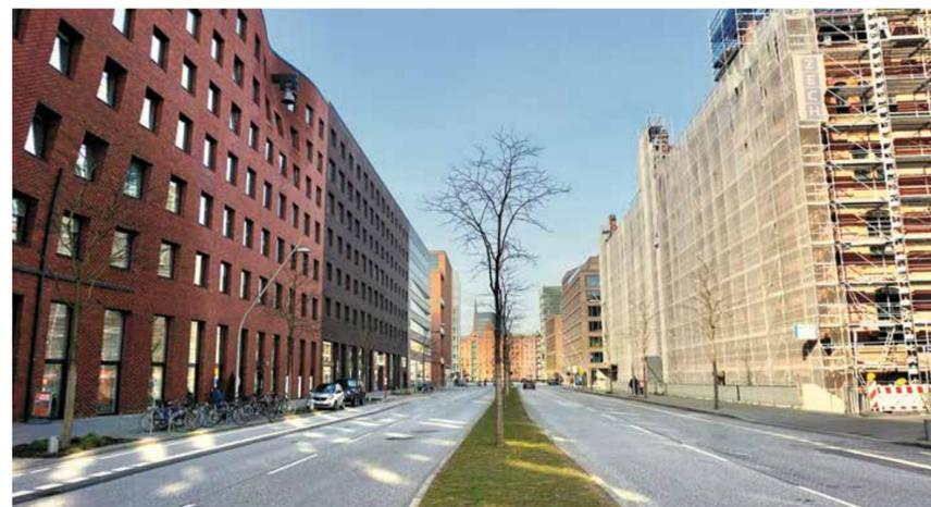
Vierspurig ausgebaute Innenstadtzubringer Shanghaiallee: Raumbreite ca. 33 m, 4 Spuren für Kfz., schmale Fuß- und Radwege, knapper Grünstreifen. Prognose Verkehrsbelastung: Frequenz bis zu 21.300 Kfz. je Tag.
