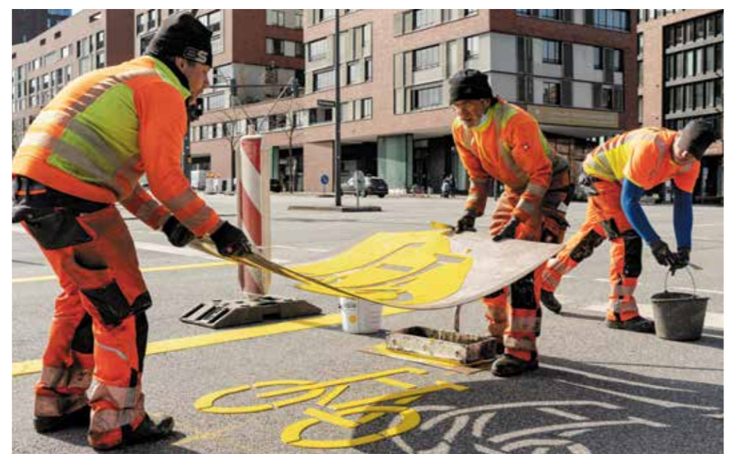
Mitarbeiter der HBV, der Hanseatischen Baustellen- und Verkehrssicherung, bereiten ab fünf Uhr morgens die Pop-up-Bikelane am Sandtorkai / Bei St. Annen vor.
