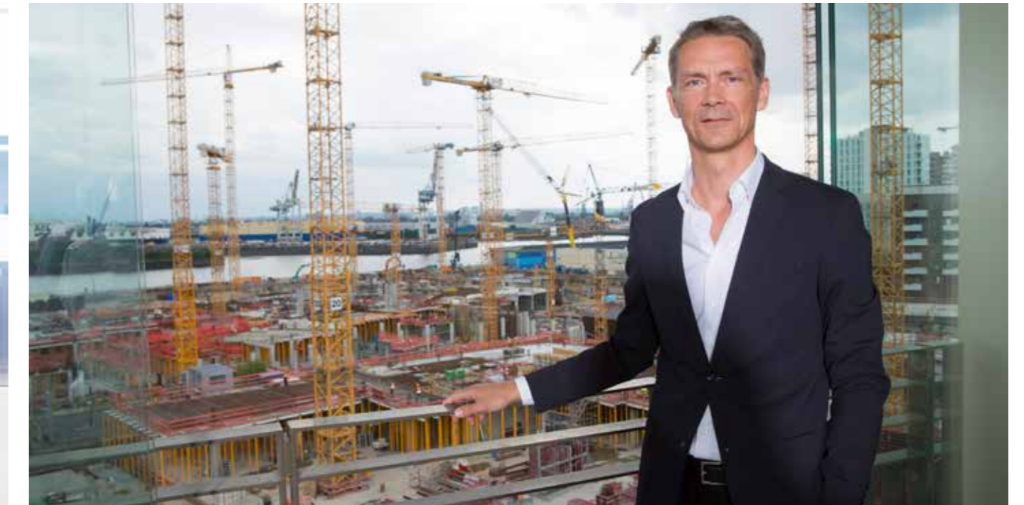
Breuninger-CEO Holger Blecker vor der aktuellen Baustelle Überseequartier: „Was hier in der HafenCity entsteht, ist eines der spannendsten Stadtentwicklungsprojekte Europas und daran möchten wir aktiv teilhaben.“
