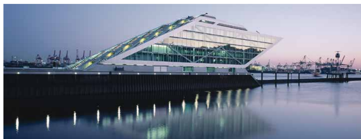
Bürohaus Dockland, 2008: Das Dockland wetteifert mit seiner glasklaren Symmetrie und der vom Hafenwind verwehten schrägen Bürogebäude-Skulptur abstrakt mit den ein- und ausfahrenden Elbschiffen.
