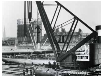
Dampfkran von 1887 am Kranhöft, der Spitze des Segelschiffhafens. Mit seiner Hubkraft von 150 Tonnen war er einer der stärksten der Welt. Hier 1936 beim Verladen eines Kessels. © GUSTAV WERRICH / IHILA
