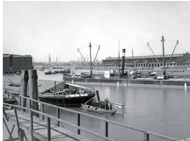
Der Moldauhafen um 1930: Im Hintergrund rechts der Schuppen, der auf der einen Seite auf Pfählen im Wasser gebaut war, sodass die Kähne direkt unter das Gebäude fahren konnten. Im Hafen liegt ein Eilgutfrachter. Beim Schiff im Vordergrund wird das Ruderblatt gereinigt. © GUSTAV WERBECK / HHLA
