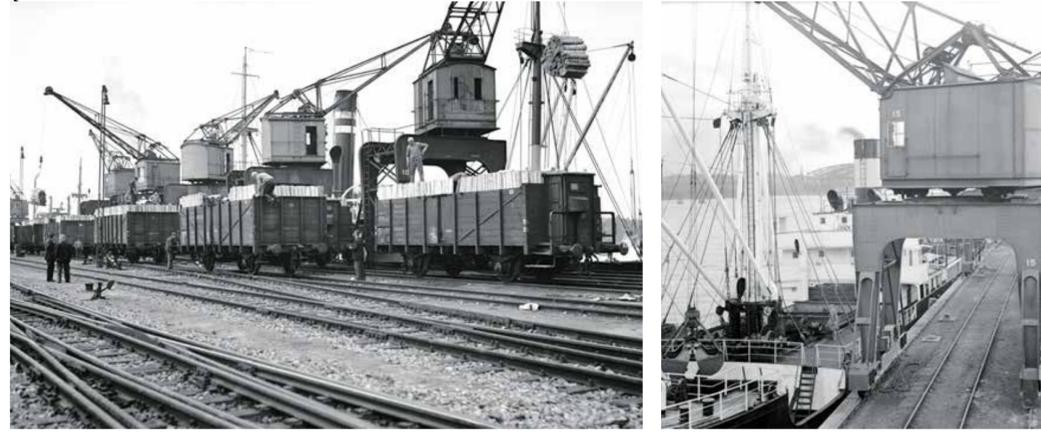
Massengüter wurden ab 1915 am Holthusenkaai auf dem Kleinen Grasbrook umgeschlagen. Hier, auf den beiden Bildern von 1930 zu sehen, werden zum Beispiel Kohle und Holz verladen. Die Güter wurden direkt aus den Waggons gelöscht, denn Stauraum für eine Zwischenlagerung gab es am Holthusenkaai nicht. Früher hatten dort die getrennten Badeanstalten für Frauen und Männer von der Veddel und aus Wilhelmsburg ihre Schwimmheimat in der Elbe. © GUSTAV WERBECK / HHLA
