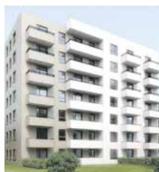
An der Stresowstraße entstehen bis zum Sommer 28 neue Wohnungen. © SAGA
