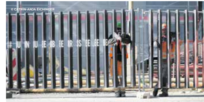
Bauarbeiterstillleben mit Kunstbauzaun #unueberseebar an der Überseeallee gegenüber vom 25hours Hotel.
