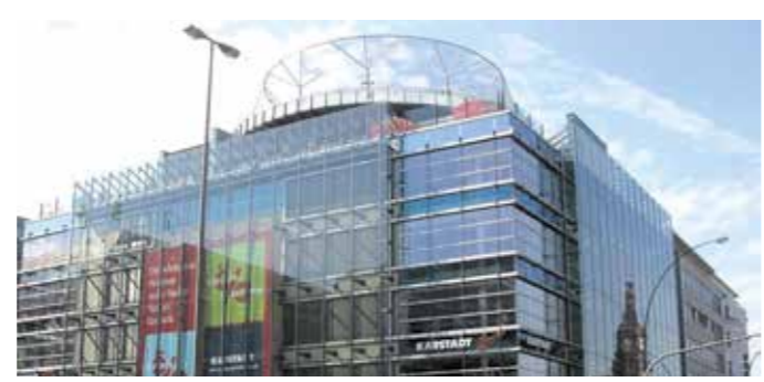
Archivbild aus dem Jahr 2007, als die Geschäfte bei Karstadt Sport noch florierten und auf dem Dach die Laufschiene probiert werden konnten. © ARCHIV/HAMBURG/DAKKE
