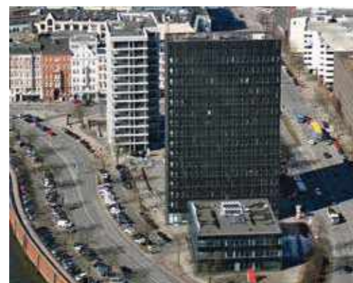
Die „Spiegel“-Insel an der Brandstwierte mit dem Ex-„Spiegel“-Gebäude (weiße Gebäude) von Architekt Werner Kallmorgen.
