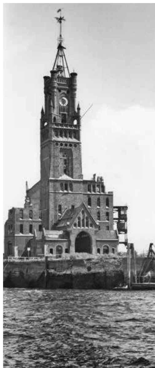
Leider mußte der schöne Turm dran glauben, er nahm zu viel Platz weg für den Neubau des Speichers.
