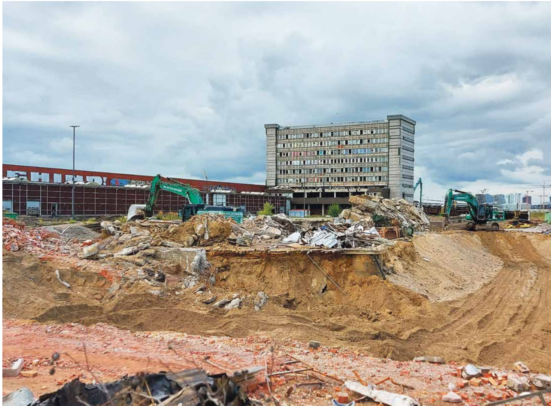
Vorbereitungsarbeiten für die landschaftsplanerische Neuanlage des „Park Veddelhöft“ (s. Visualisierung r.): Die Abrissarbeiten auf dem Kleinen Grasbrook haben begonnen. Gleisanlagen wurden entfernt und die ehemaligen Gebäude und Hallen des Übersee-Zentrums sind für den Abriss vorbereitet, bevor das gesamte Gelände bis zum Jahr 2024 auf Warftniveau gebracht wird. © MATHIAS SCHINK
