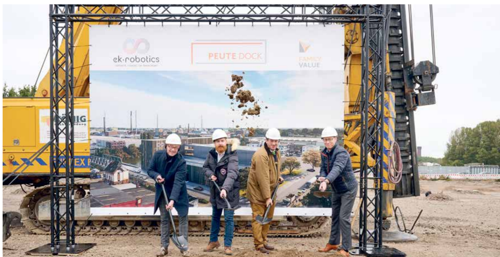
Spatenstich für die neue Unternehmenszentrale von ek robotics (v. l.): Der Architekt Markus Trautmann (ht' hörter+trautmann Architekten), Andreas Böttner (CEO ek robotics), Georg Prinz zu Salm-Salm (Partner bei Family Value Management GmbH) und Lutz M. Birke (Amtsleiter Hafen und Innovation bei BWI).
