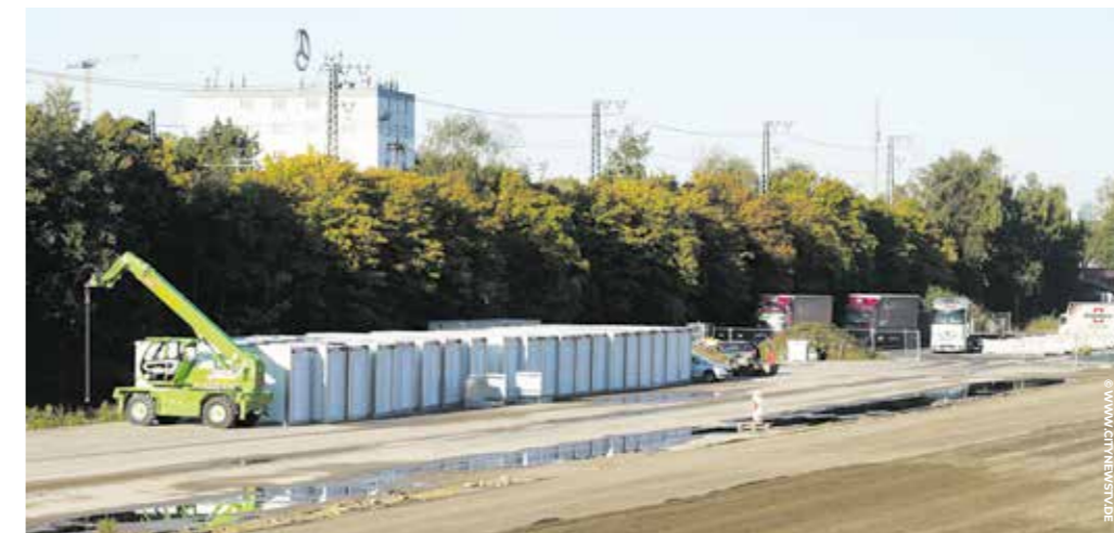
Auf dem ehemaligen Huckepack-Bahnhofsgelände im Stadtteil Rothenburgsort entsteht eine neue Großunterkunft für 500 Flüchtlinge. Die Baumaßnahmen haben begonnen.“
