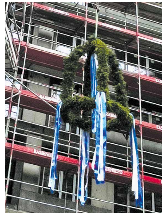
Richtkranz für das Fest der Bauarbeiter zur Fertigstellung des Rohbaus. © Catrin-Anja Eichinger
