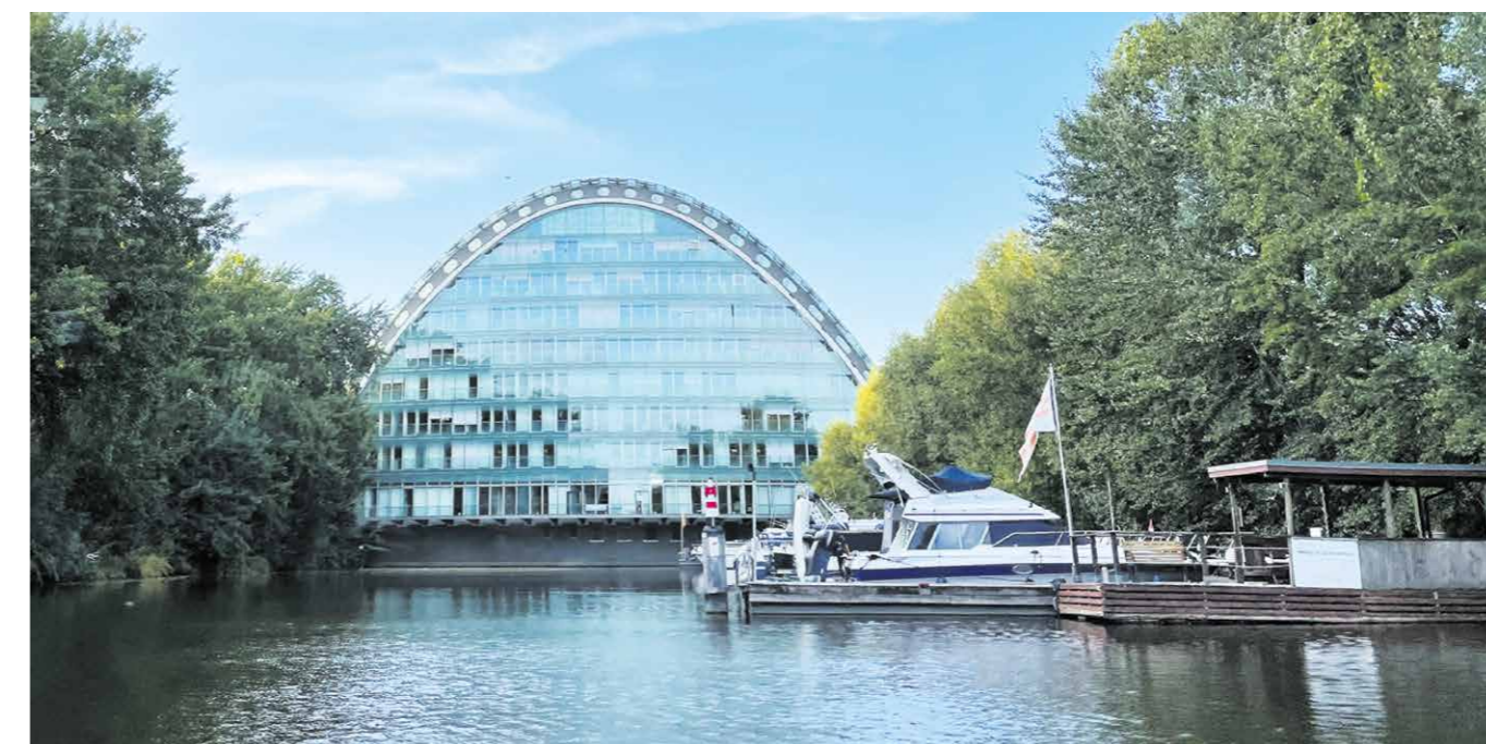
Das hochdekorierte Architektur-Juwel Berliner Bogen in Hammerbrook an einem Bille-Seitenkanal und in Nachbarschaft zu St. Georg und der Hafencity: Organisiert durch die Friedrich-Ebert-Stiftung bricht eine Gruppe Neugieriger an Bord einer Barkasse zu einer Tour in das oftmals unbekannte Bille-Gewässer im Hamburger Osten auf. © Kim Katarina Klocke
