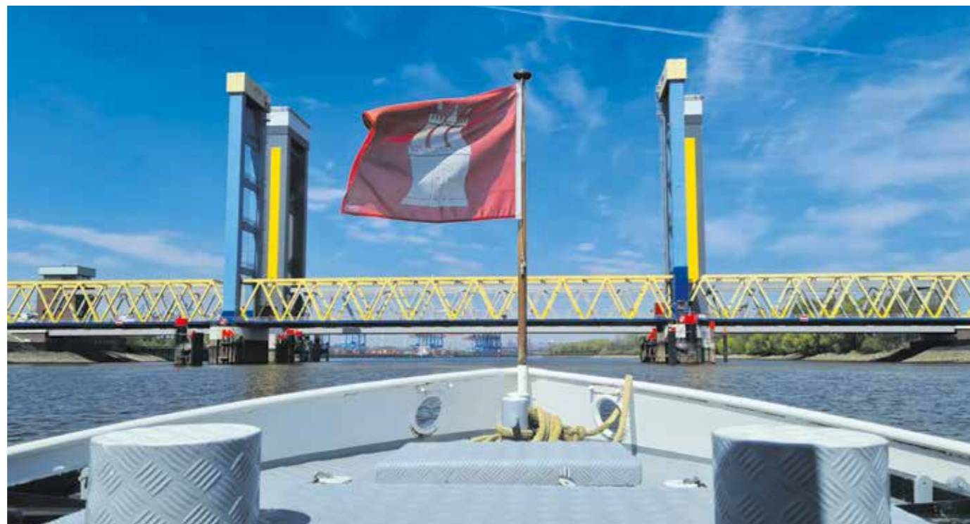
Die historisch einzigartigen hydraulischen Kattwykbrücken für Kfz- und Eisenbahnverkehr im Hafen. © ELBINSSEL-TOUR
