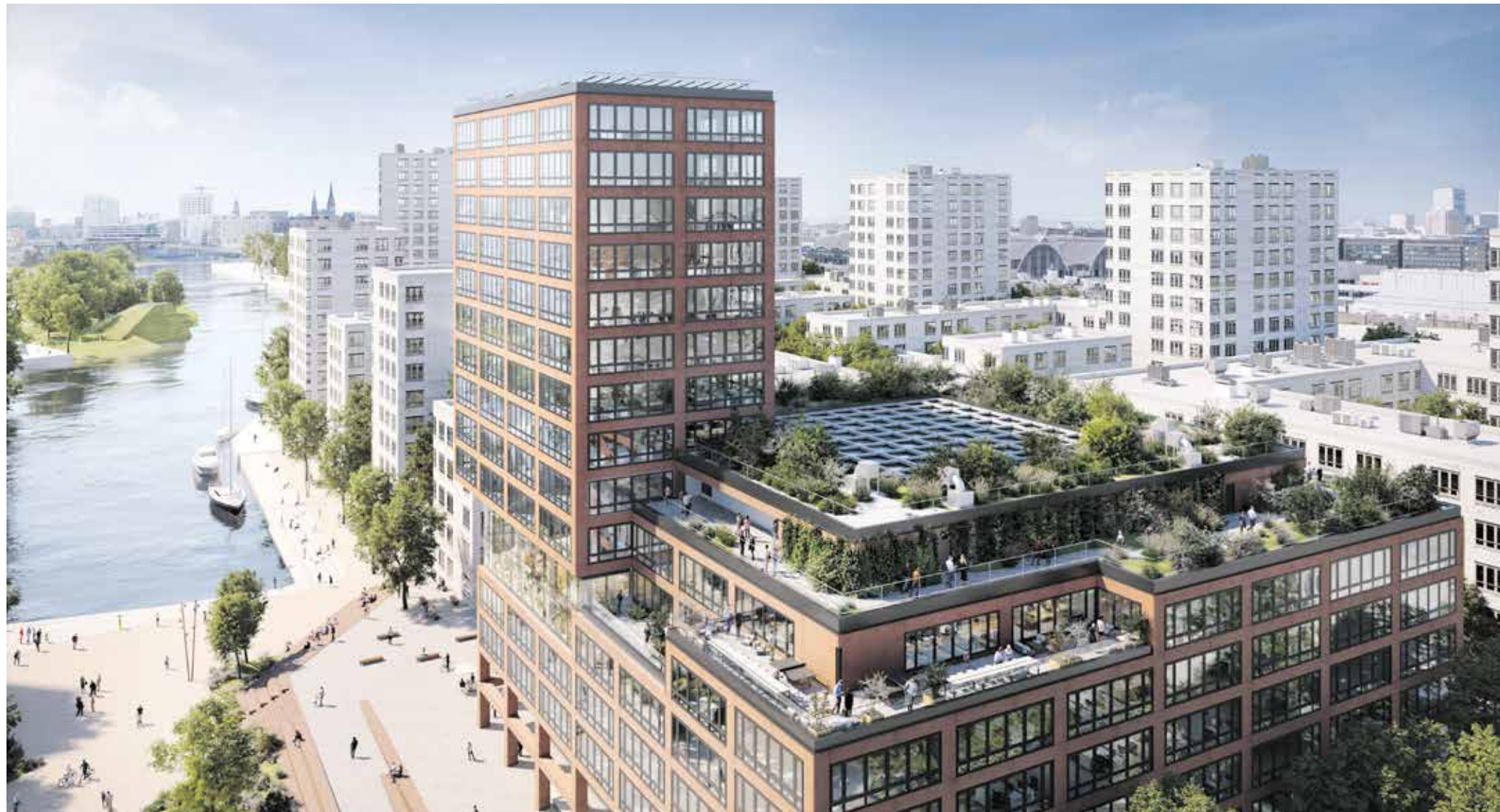
3 Die energieeffiziente Büroimmobilie Edge HafenCity Hamburg setzt auf 22.500 Quadratmetern mit ihrer imposanten Architektur, ihren über 6.000 Quadratmetern geteilten Gemeinschafts- und Erholungsflächen sowie ihrer hochvernetzten Gebäudesteuerung Maßstäbe für flexible, intelligente und innovative Arbeitswelten von morgen. © BLOOM IMAGES
