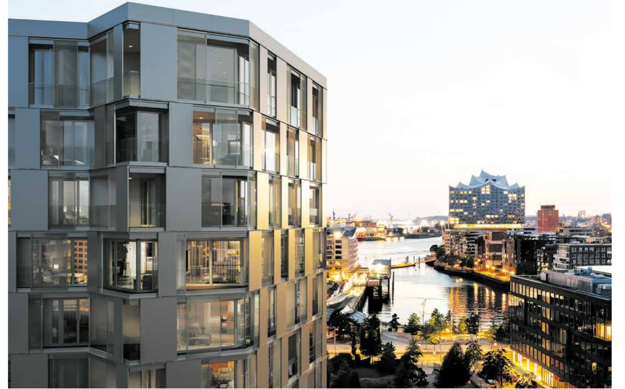
Verschiebbare Aluminium-Fensterläden an der „The Lyte“-Fassade erlauben individuellen Licht- und Sonnenschutz und spiegeln im Abendlicht die Atmosphäre der Hafencity wider. © DC Developments
