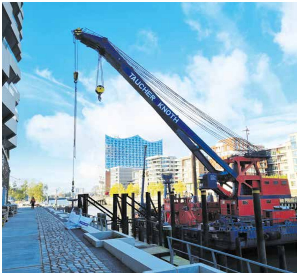
Endspurt zum Rückbau von 78 Pfählen für neun Plattformen mit insgesamt 115 Tonnen Gewicht.
