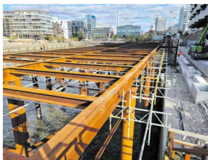
Ein letzter Blick auf die Rahmen und Pfähle des Pontons mit 46 Meter Länge und 20 Meter Breite.
