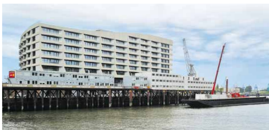
165 wasserseitige Strandkai-Container kurz vor ihrer Demontage. © Fotos (4): Gerd Reich | Taucher Knoth
