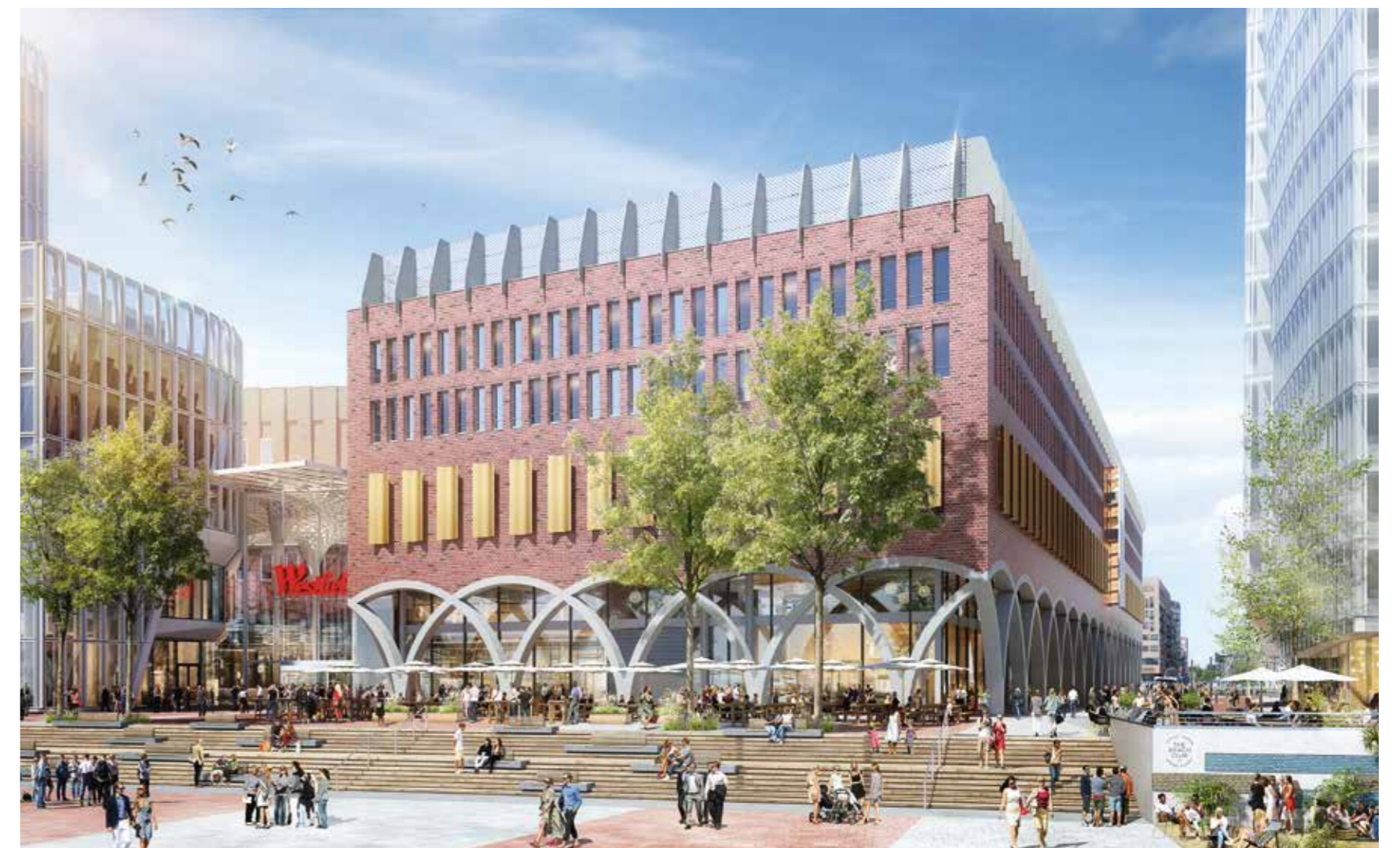
Mit dem „Waterfront“-Bereich können HafenCitizens, Hamburgerinnen und Gäste des Überseequartiers zum ersten Mal das Elbufer der früher größten innerstädtischen Baustelle Europas ab 25. April selbst kennenlernen. Dennis Thering zum neuen Megazentrum: „Man sehnt sich auch und gerade dort nach einer besseren Verkehrspolitik, nach deutlich mehr und vor allem auch gepflegten Grünflächen – und das wurde bei allen guten Planungen doch weitestgehend vergessen – nach attraktiven Sportmöglichkeiten. Die HafenCity finde ich persönlich mit ihrer Lage an der Elbe hochattraktiv und ein gutes Beispiel dafür, wie zukunftsweisend moderne Stadtentwicklungspolitik funktionieren kann.“ © NOKA-STUDIO | URW
