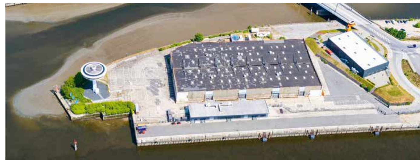
Der ungestaltete Baakenhöft mit der temporären Nutzung als Kreuzfahrterminal, dem Wohn-Leuchtturm-Projekt „Lighthouse“ und dem gelegentlich als Ausstellungsfläche genutzten Schuppen 29. © PICTURE ALLIANCE / ZB/EUROLUFTBILD.DE | TOBIAS BARTH
