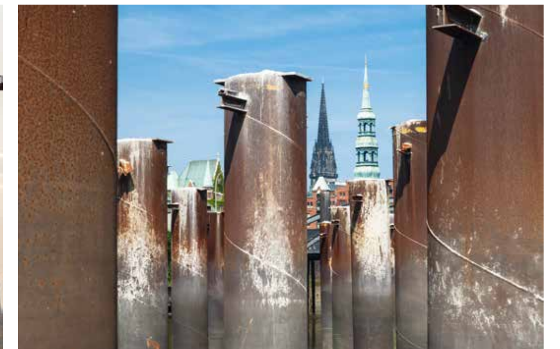
Durch die Fundamentpfiler des abgerissenen Frigotransit-Kühlhauses am Magdeburger Hafen fällt der Blick auf die Türme von St. Katharinen und St. Nikolai sowie die Speicherstadt – heute ruht auf denselben Stützen die Promenade vor den Elbarkaden. © THOMAS HAMPEL
