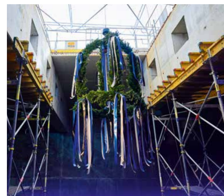
Richtkranz des UBS Digital Art Museums vom Untergeschoss ins EG gezogen – deshalb nannte es sich: „Deckenfest“. © CATRIN-ANJA EICHINGER
