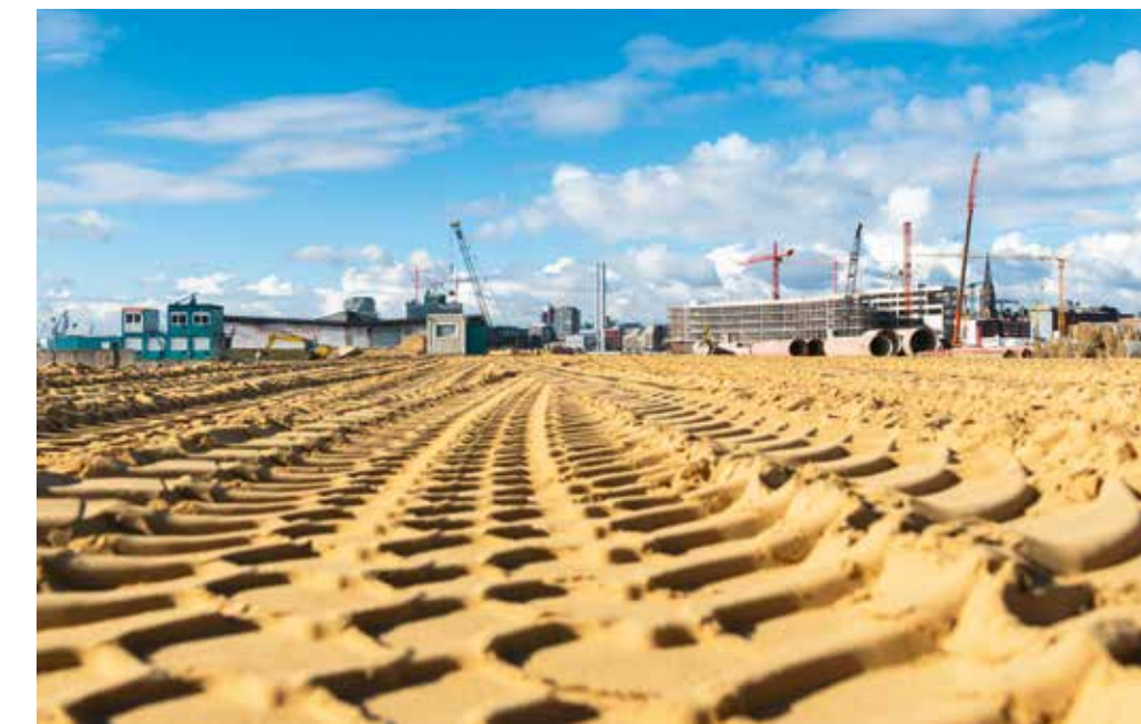
Die heutige Baakenallee im Jahre 2012, der weite Blick geht bis zum halb abgerissenen Schuppen 29 und den Röhren für die Fundamente der Baakenhafenbrücke, im Hintergrund entsteht die Hafencity Universität, links daneben sind in der Ferne das Heizkraftwerk, das Gebäude von Kühne + Nagel und das Hanseatic Trade Center zu erkennen. © THOMAS HAMPEL
