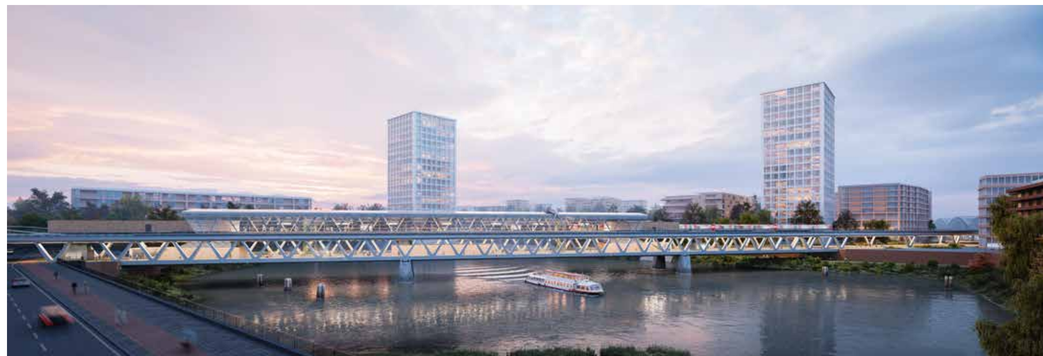
Elegant schwebt die U4-Station Moldauhafen über dem Hafenbecken, unter ihr werden Fußgängerinnen und Radfahrerinnen den Weg nach Süden nutzen können. VISUALISIERUNG: © MOKA-STUDIO
