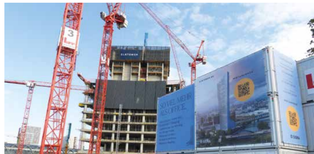
Der Insolvenzverwalter verhandelt zurzeit ausschließlich mit der Becken Development GmbH über einen Kauf des Elbtowers. © FRANK BRÜNDEL | WWW.CITYNEWT5.DE
