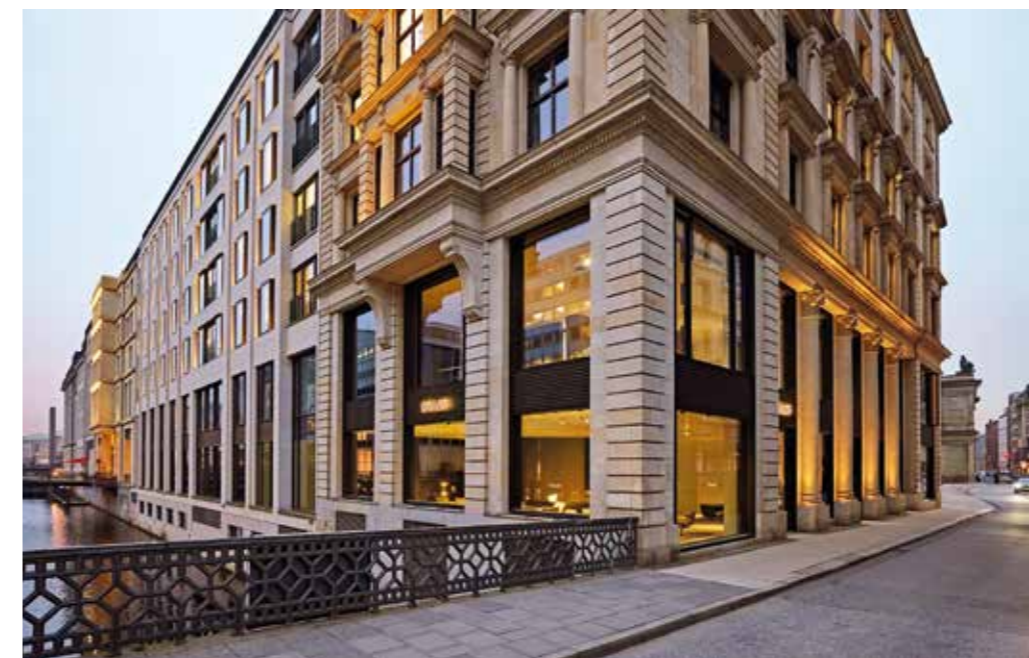
Edeladresse Alter Wall 32 mit dem neuen Luxus-Flagship-Store von Minotti: Schon von außen fällt das Pesch-Gebäude durch die spektakuläre Natursteinfassade in Sandtönen auf, die auf drei Seiten nicht weniger als 13 große Fenster pro Etage aufweist. © MINOTTI HAMBURG BY PESCH
