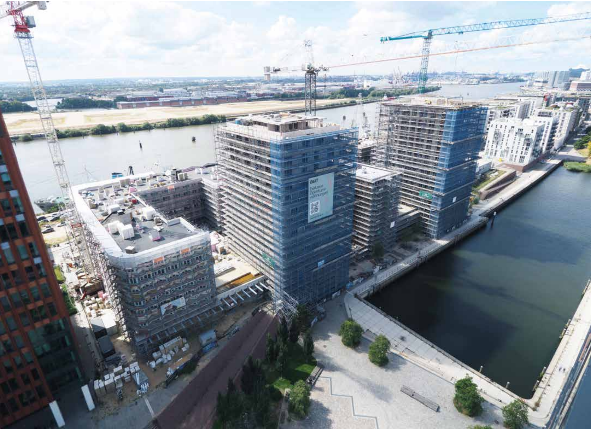
Baufortschritt September 2025 fürs Quartier »Tide« mit seinen beiden eingerüsteten Wohntürmen »Beat« (l.) und »Pulse« mit beidseitiger Wasserlage an Elbe und Baakenhafen. © ECE
