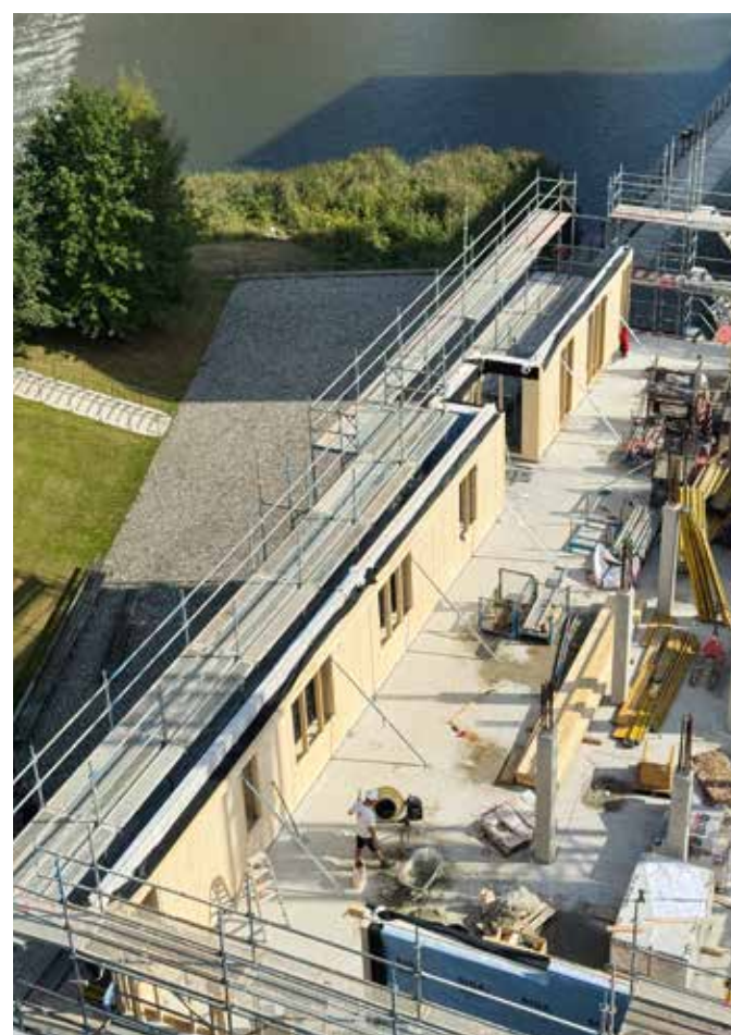
Effiziente Bauweise und vorgefertigte Serienproduktion: Die tragenden Außenwände werden bereits im Werk mit Wärmedämmung und Lüftungseinbauten als bis zu 14 Meter lange Elemente vorgefertigt. © ARCHY NOVA
