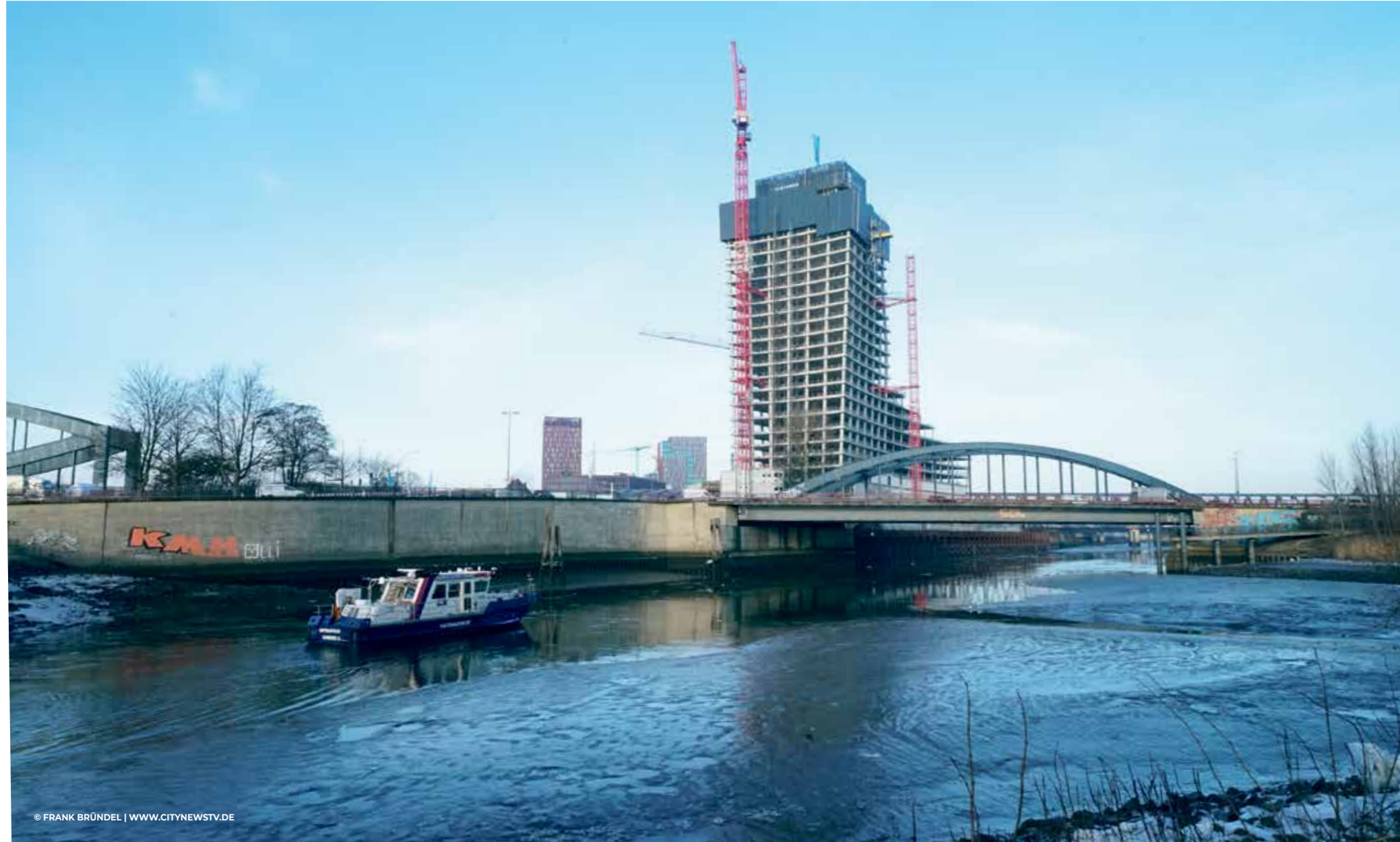
Die 100 Meter hohe Bauruine Elbtower soll mit dem neuen städtischen Naturkundemuseum, Büros und einem Hilton-Luxushotel bis 199 Meter Höhe vollendet werden.
