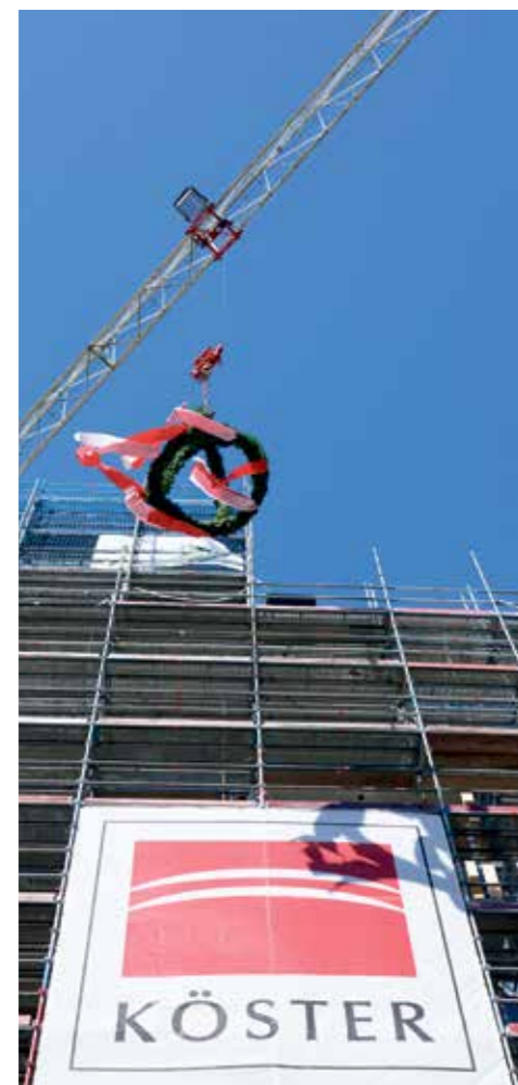
Rot-weiße Flatterbänder signalisieren Bauunternehmer und Bauherrn: Der Rohbau ist übergeben. Fotos (D): CATRIN-ANJA EICHINGER
