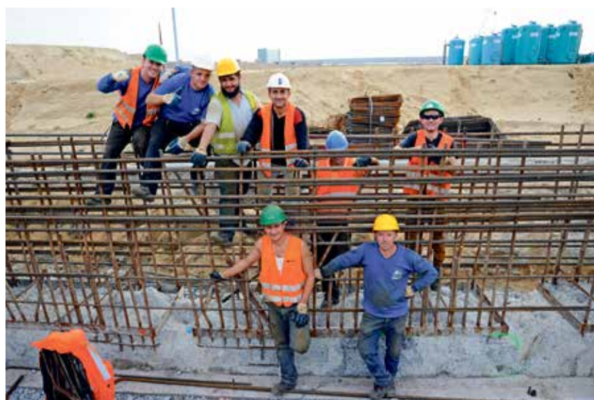
Herbst 2014 – Armierungsarbeiten für die Ausfahrtstampe der U4 aus dem Tunnel kurz vor den Elbbrücken. © WOLFGANG HUPPERTZ
