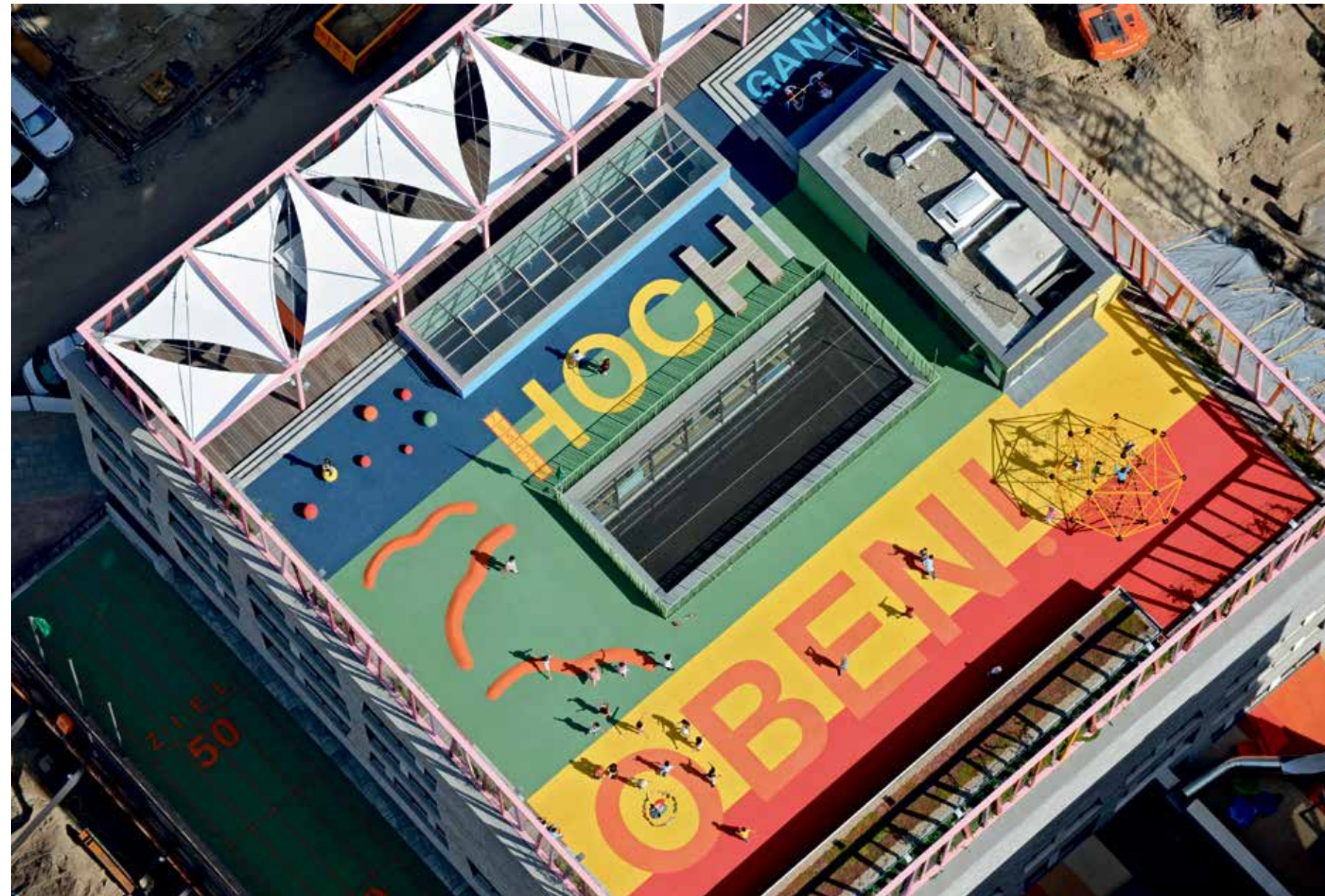
Der spektakuläre Pausenhof auf dem Dach der im Sommer 2009 eröffneten Katharinschule am Sandtorpark. © THOMAS HAMPEL
