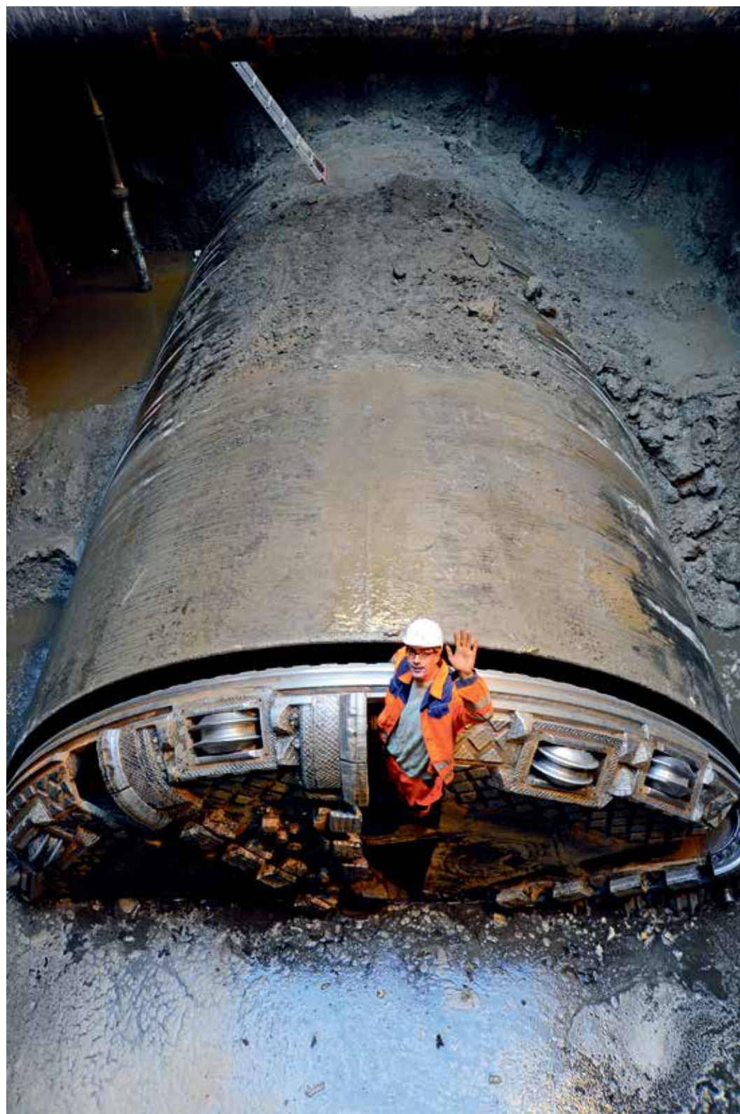
Am 20. Oktober 2009 hat die Vortriebsmaschine auf ihrem Weg von der HafenCity zum Jungfernstieg einen ersten 2,8 Kilometer langen Tunnel gebohrt und dabei fast 100.000 Kubikmeter Erde abgebaut. © WOLFGANG HUPPERTZ
